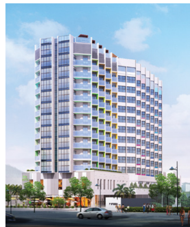
Dự án đang xây dựng
